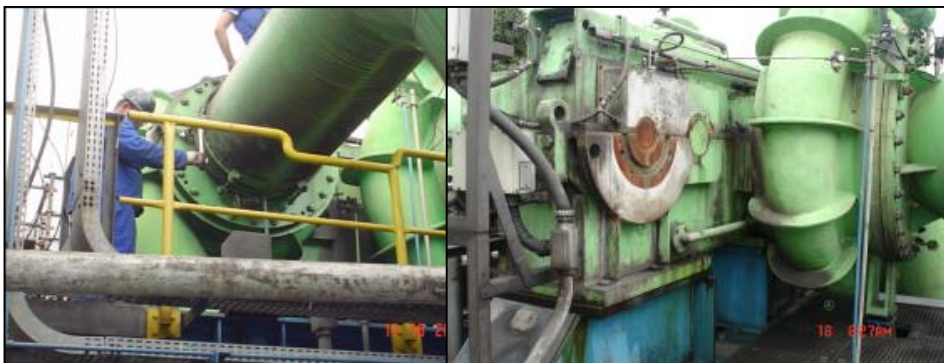
Figura 19. Compressor CP-101 antes e após a retirada do 3º estágio. (2)
