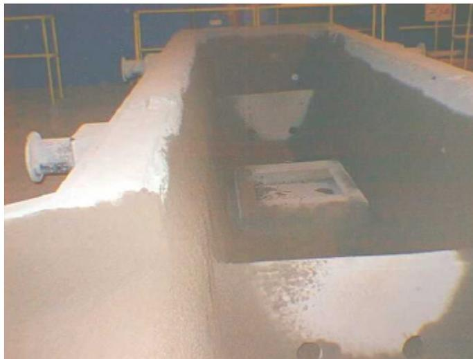
Figura 8 – Foto do distribuidor da mcc#4 montado com turbostop e dique
