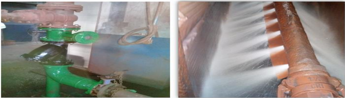
Figura 12 – Filtro de malha 1,0 mm e instalação de ar comprimido no jateamento
