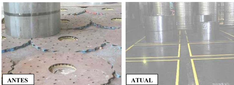
Figura 8. Substituição convectores pelas chapas de piso.
