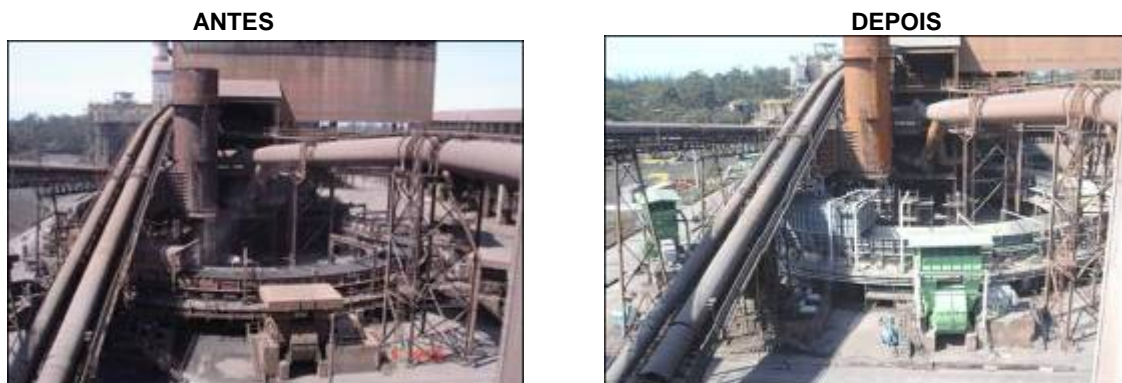
Figura 9. Imagens do Resfriador antigo e do novo Resfriador, fornecido pela Paul Wurth.
