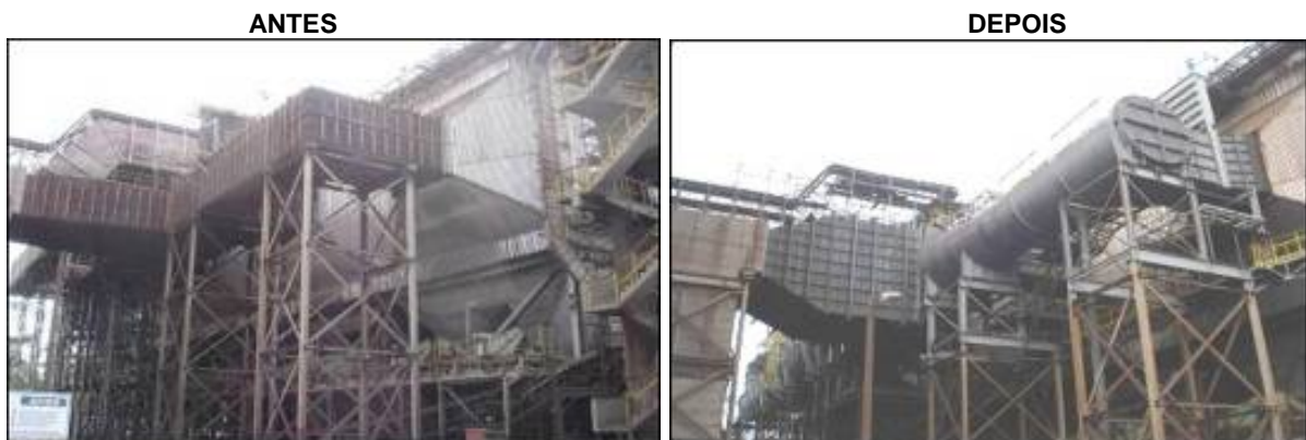
Figura 11. Imagens dos dutos dos Precipitadores eletrostáticos de antes e depois da parada. (1)
