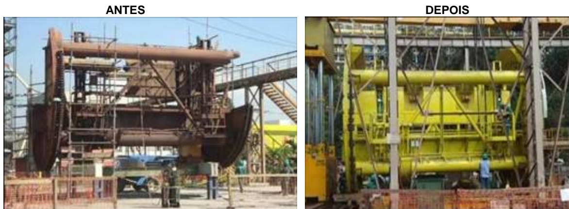
Figura 14. Imagens do Virador de vagões antes e depois da reforma. (1)
