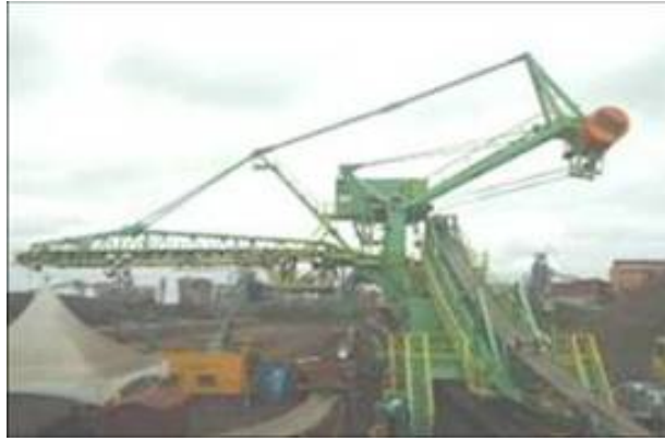
Figura 12. Imagens do BS ( Blending Stacker ) após a reforma. (1)
