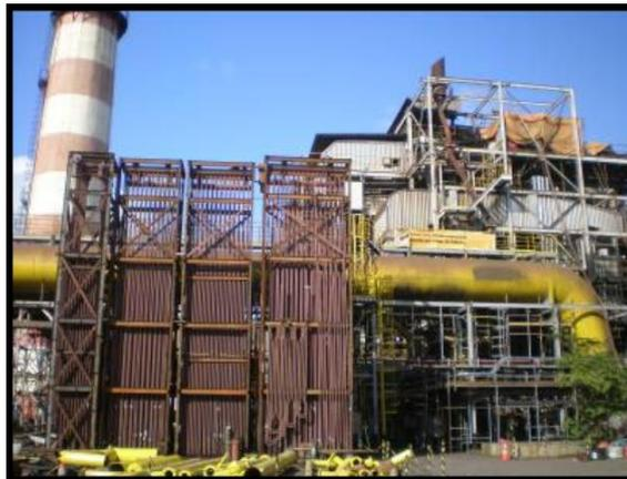
**Figura 6.** Substituição dos superaquecedores.
