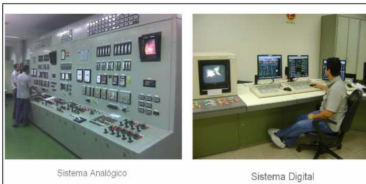
**Figura 10.** Sala de Controle – Interface Homem-Máquina.
