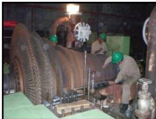
Figura 13. Substituição do eixo da turbina.
