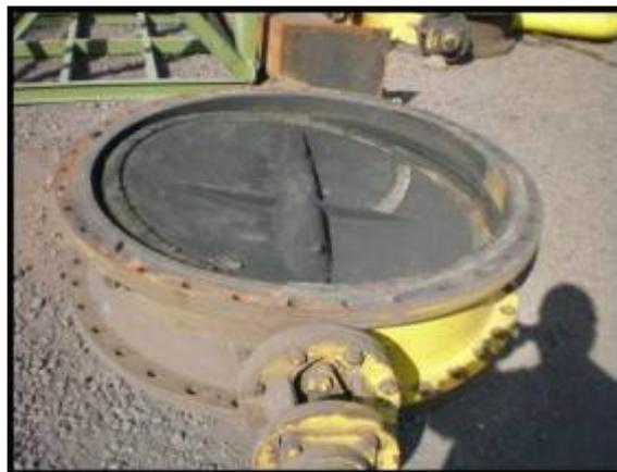
**Figura 8.** Substituição da sede de válvulas de gás.
