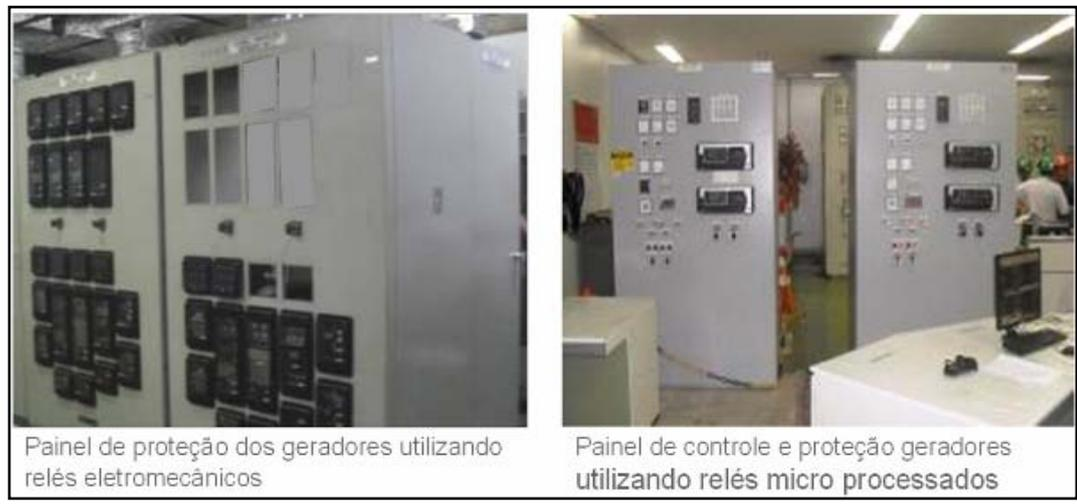
Figura 16. Substituição dos sistemas de comando e proteção eletromecânicos
