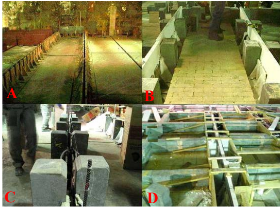
Figura 7 – Preparação da soleira para bombeamento
