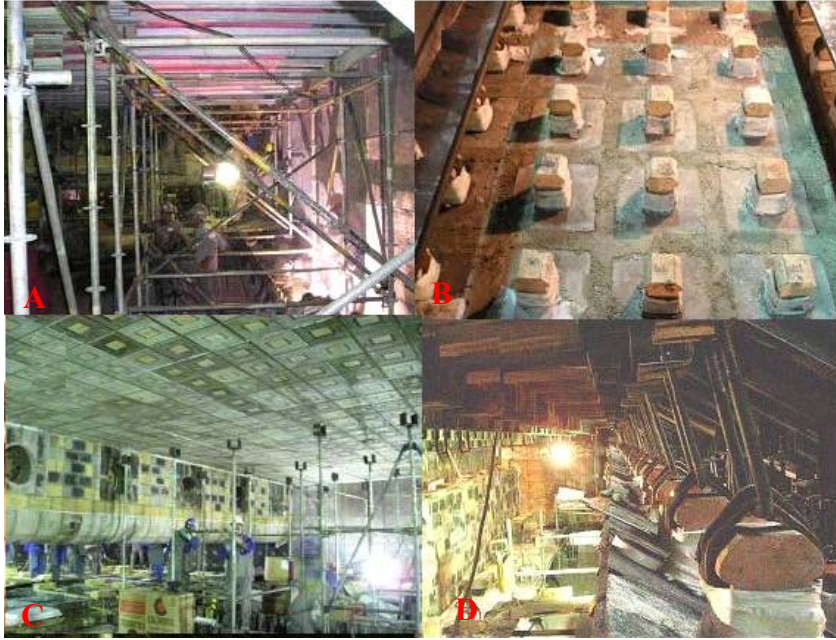
Figura 6 – Montagem do teto
