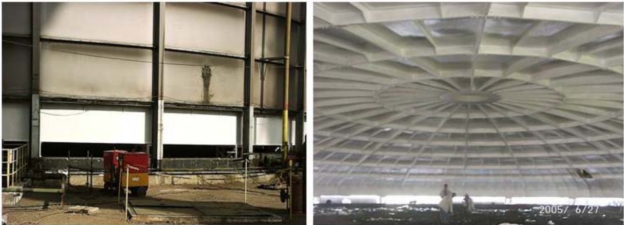
Figuras 8 e 9. Vista da chapa que compõem caixa de sustentação do anel de concreto e parte inferior do teto do pistão, ambas revestidas com acabamento anticorrosivo.
