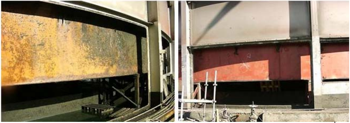
Figuras 6 e 7. Vista da abertura na base do gasômetro: à esquerda, chapa com sinais de corrosão. À direita, nova chapa com revestimento anticorrosivo.
