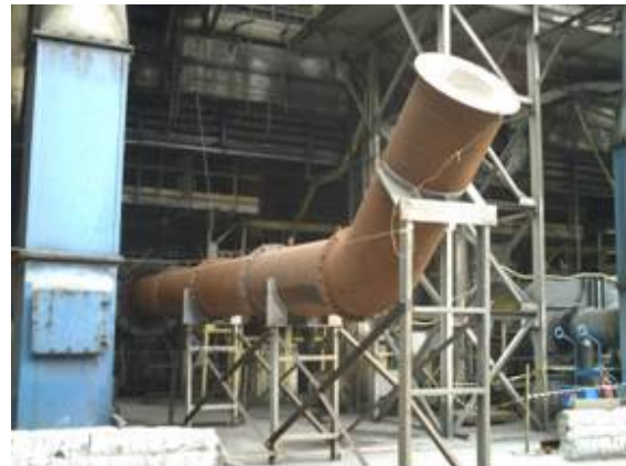
b) Temporary Chimney
