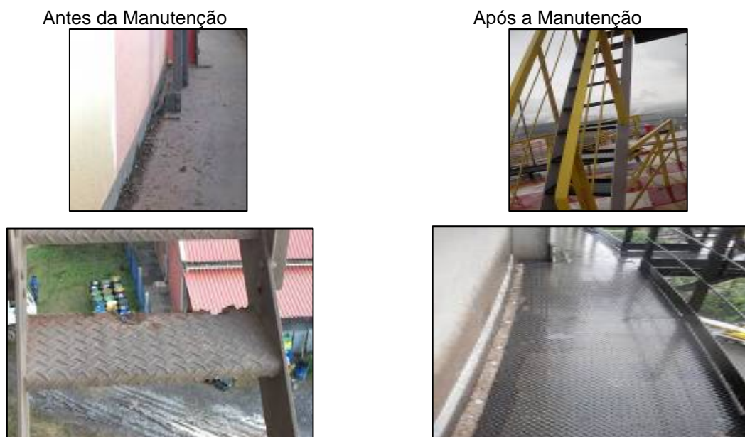
Figura 13. Estruturas Metálicas do Gasômetro mantidas durante a Parada Programada.
