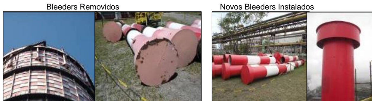
Figura 12. Bleeders do Gasômetro de BFG.
