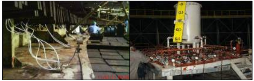
Figura 14. Sistema de graxa do gasômetro.
