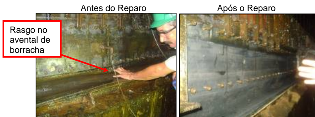
Figura 4. Avelamento de borracha da selagem.
