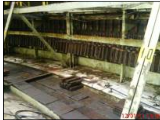
Figura 6. Pistão após limpeza com vapor.
