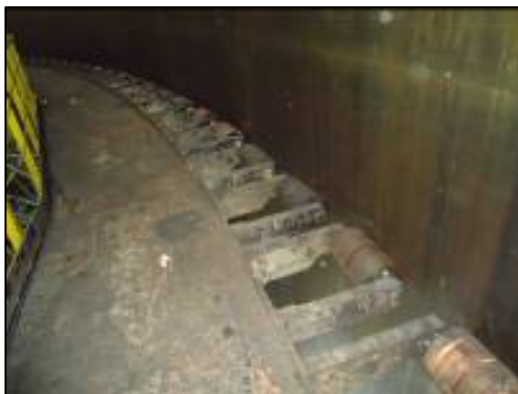
Figura 8. Fileira superior de rolos do sistema de nivelamento original do pistão.
