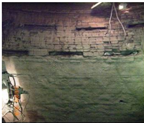
Figura 19. Aplicação de gunning na cuba. (3)
