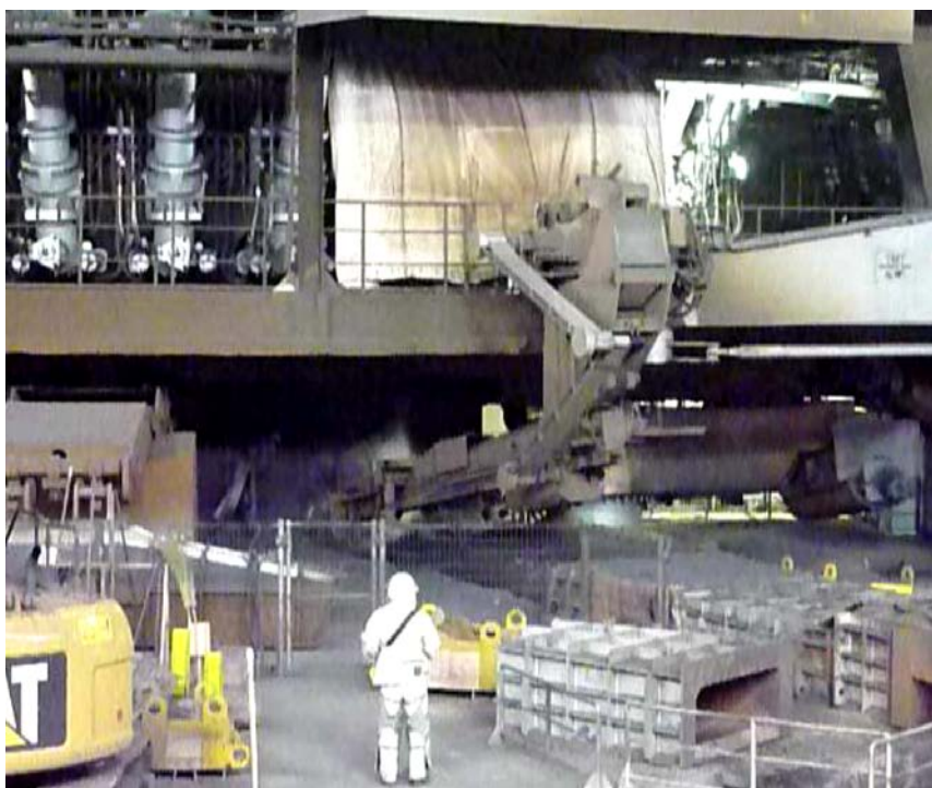
Figura 15. Cercamento de área da perfuratriz e canhão de tamponamento
