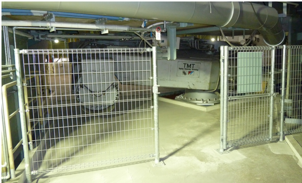
Figura 13. Cercamento de área
