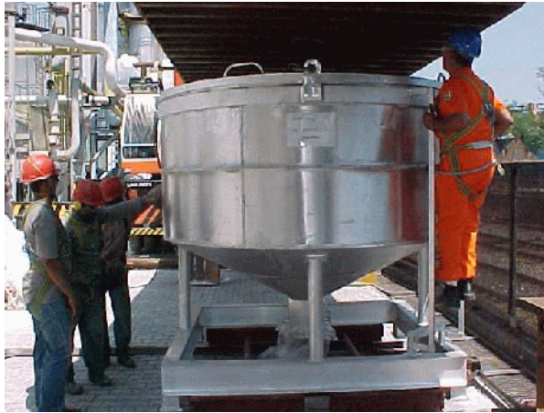
Figura 9. Enchimento dos silos
