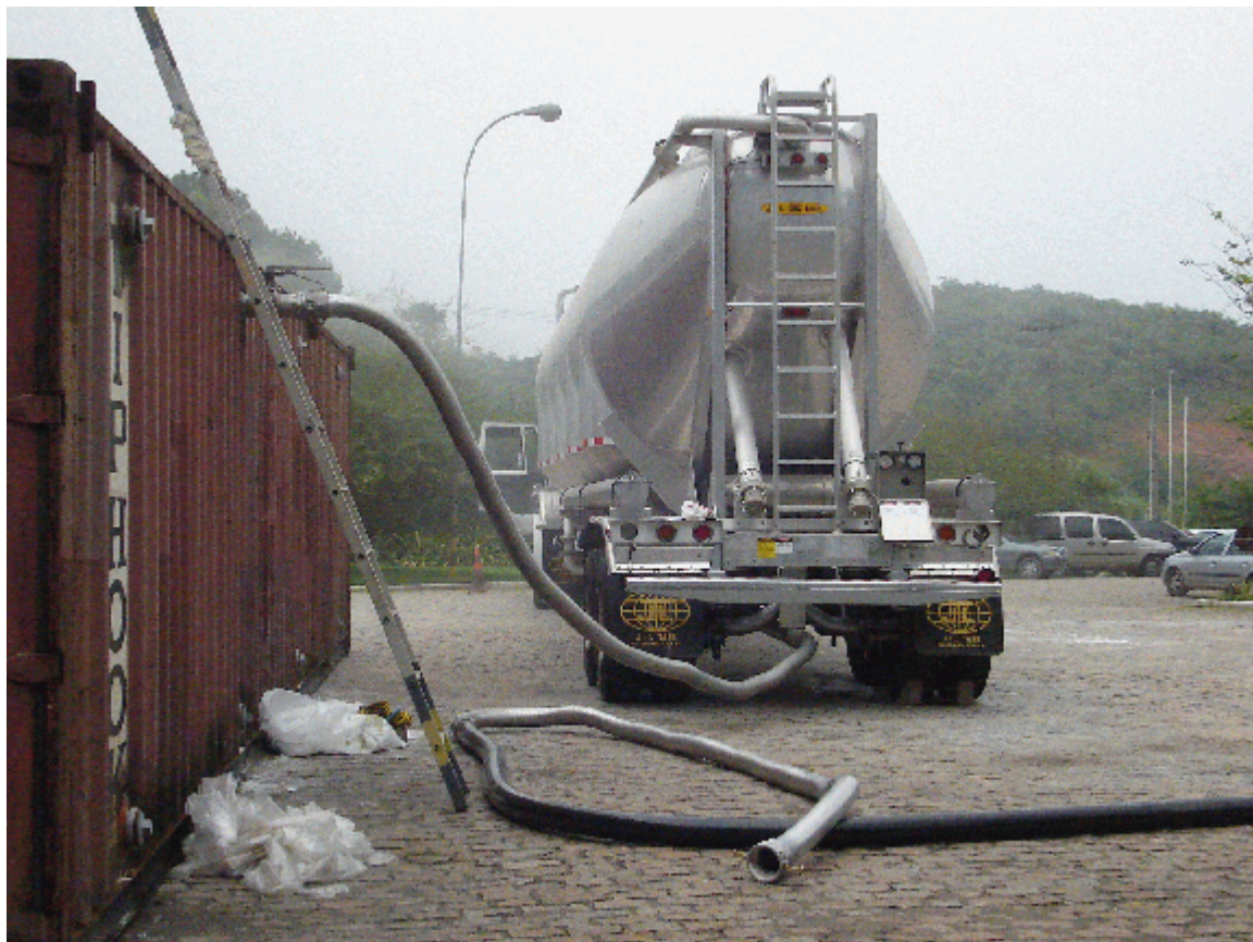
Figura 8. Transferência da perlita para o container de armazenamento.
