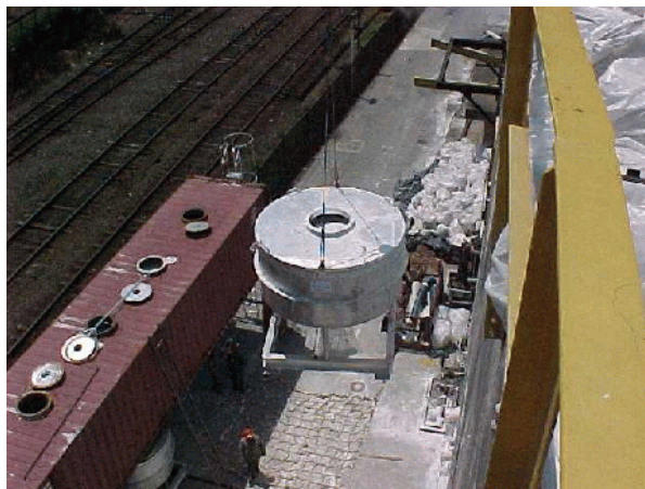
Figura 10. Içamento dos silos
