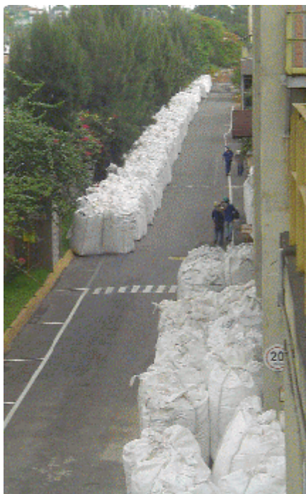
Figura 5. Potencialização dos problemas de armazenagem da perlita retirada.
