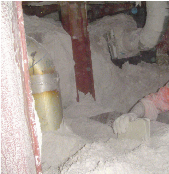
Figura 4. Fundo do Cold Box requerendo coleta manual.
