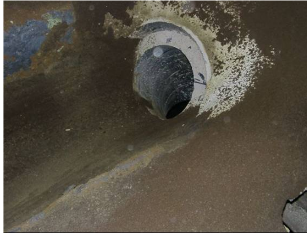
Figura 8 – Imagem da contrabica proposta montada antes do início de operação.
