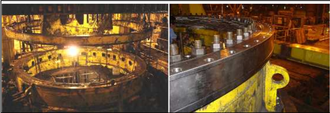
Figura 14 – Rolamento velho (esquerda) e novo (direita).
