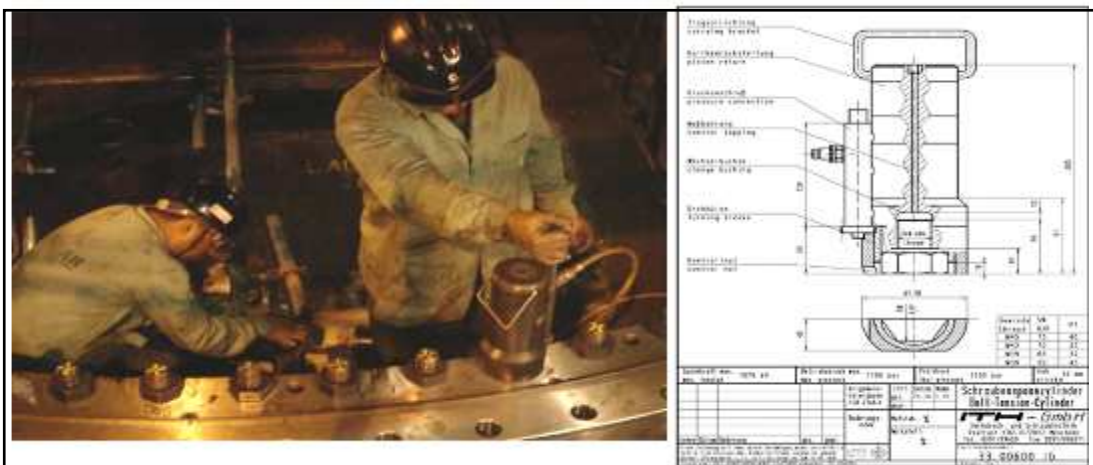
Figura 16 – Dispositivo de pretensão hidráulica e execução da atividade.
