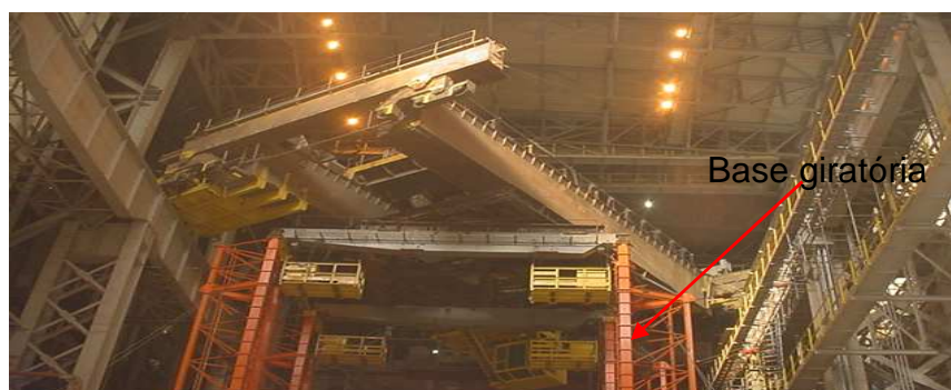
Figura 10 – Metodologia de transposição de ponte rolante - Giro da ponte rolante.
