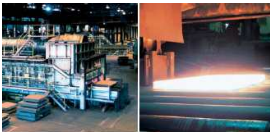
Figura 8. Forno da Outokumpu reformado com queimadores Rebox.
