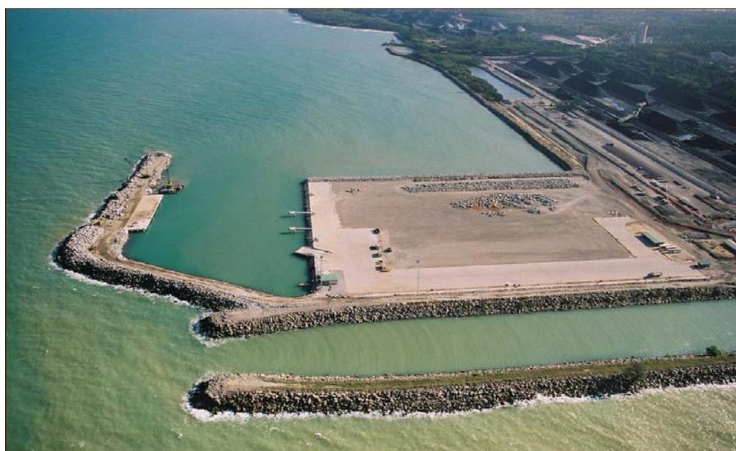
**Figura 4** - Layout do Terminal em fase final de construção
