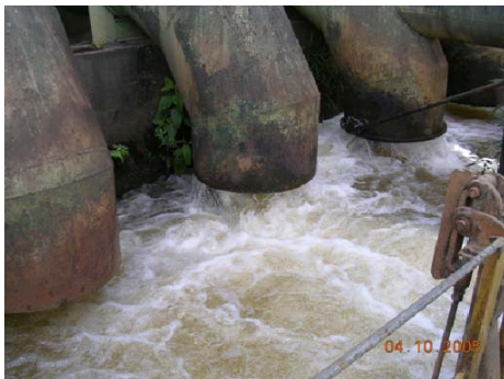
Figura 1. Caixa de chegada da água bruta
