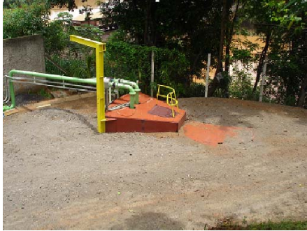
Figura 16. Vista do poço de recebimento de toda gerada na ETA
