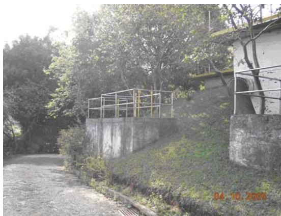
Figura 14. Poço de visita de concentração de parte dos Efluentes da ETA da Acesita S.A
