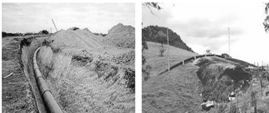
Figura 1 – Tubos centrifugados de ferro fundido utilizados na condução de água. (4)
