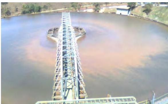
**Figura 14.** Aspecto usual do espessador de lamas EP –51 sendo afetado pela dispersão química da deslamagem.
