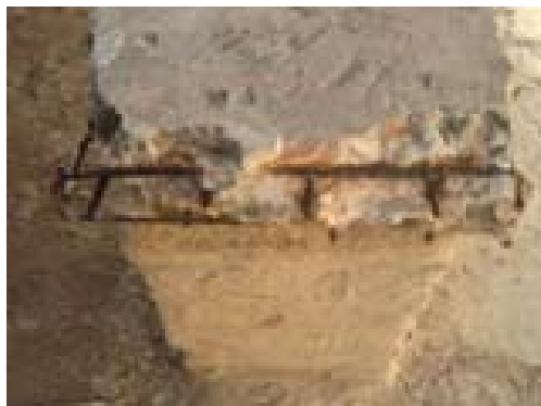
Figura 15. Removedor de ferrugem aplicado nas ferragens.
