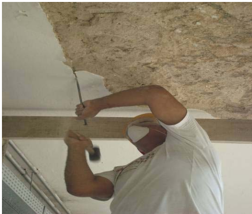
Figura 20. Destacamento do reboco.
