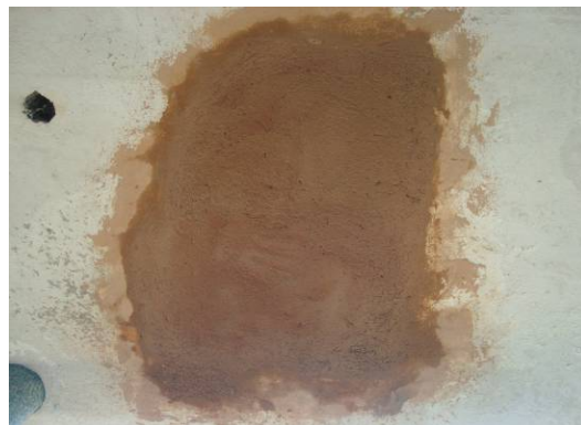
Figura 23. Argamassa aplicada.
