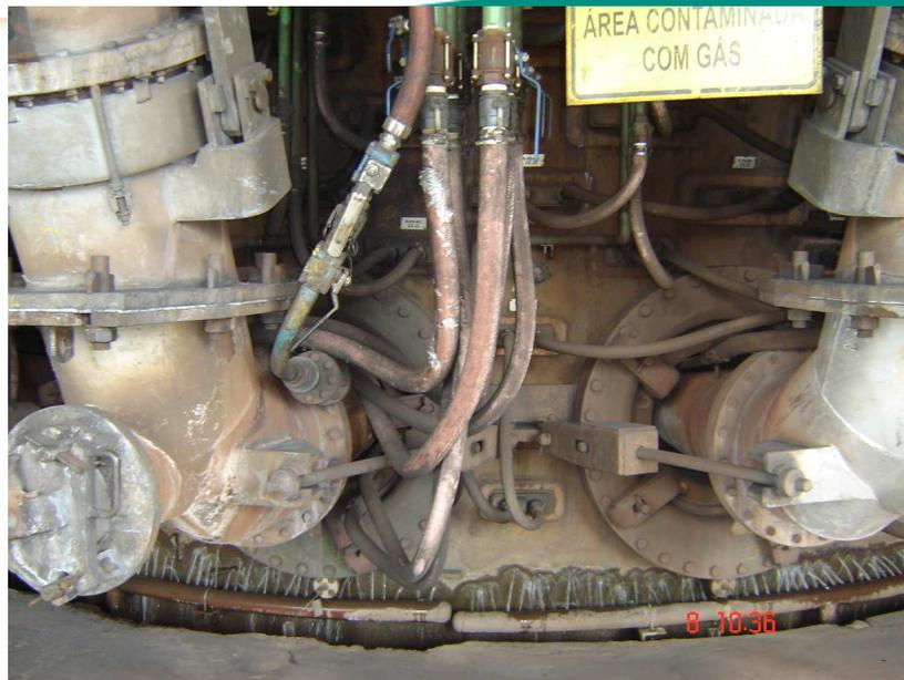
**Figura 5** - Posicionamento da lança simples de injeção de finos original em um algarviz do Alto-Forno 2.
