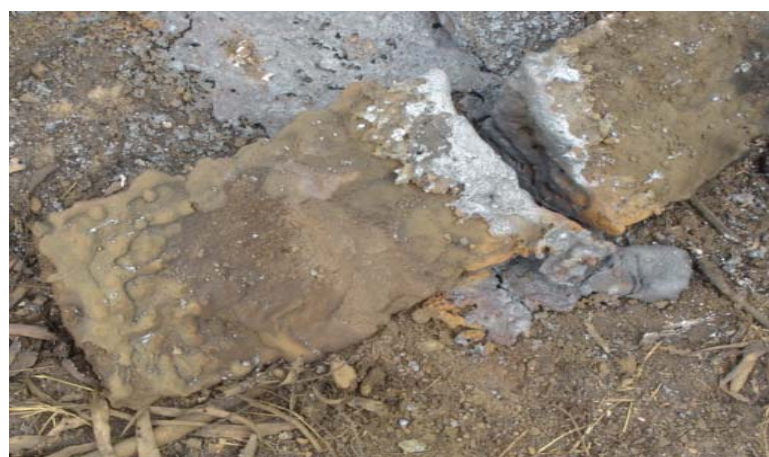
Figura 4- Corte com lança preenchida de aço
