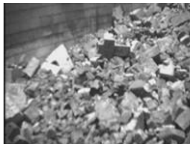
Figura 5. Desmoronamento de tijolos em um regenerador de alto-forno.
