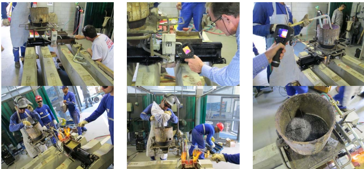
Figura 4. Etapas de preparação da junta aluminotérmica - continuação.
