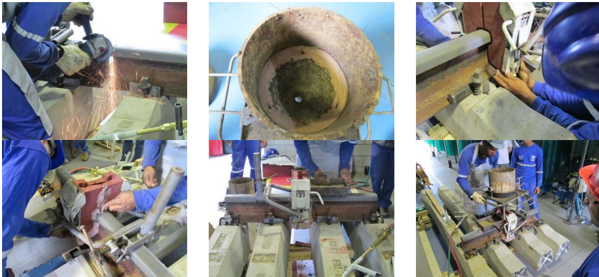
Figura 3. Etapas de preparação da junta aluminotérmica.
