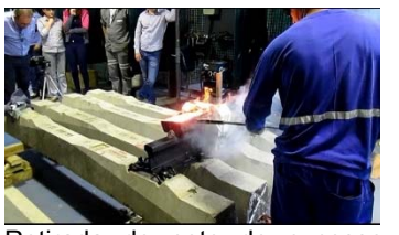
Retirada do pote de excesso e escória (alumina) 10m:23s
