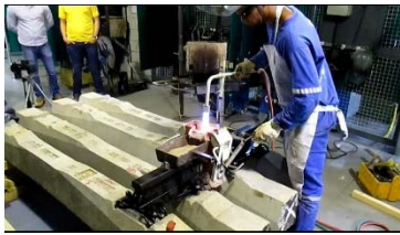
Início do pré-aquecimento do molde 00m:00s
