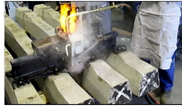
Desprendimento de gases no pré-aquecimento 07m:26s
