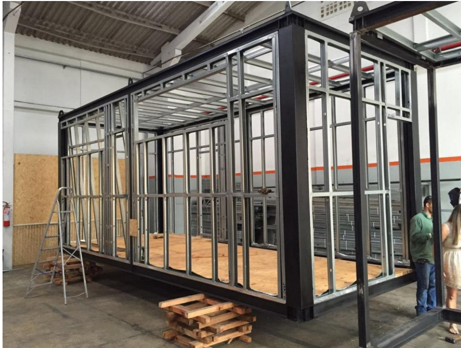
Figura 1. Estrutura em aço do vestiário.
