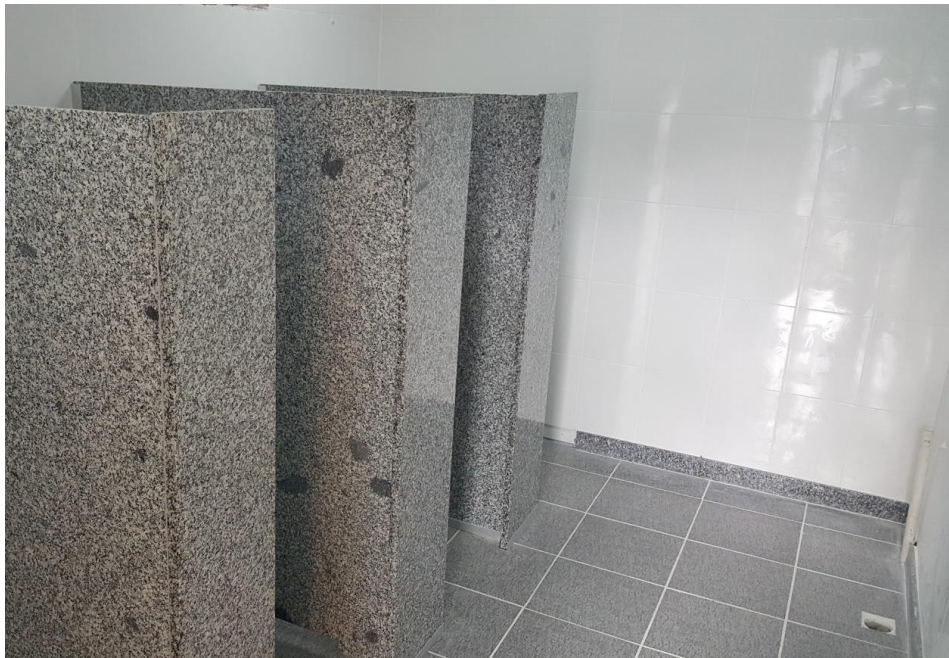
Figura 2. Acabamento interno do vestiário.
