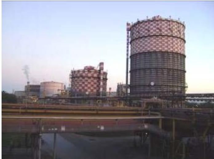
Figura 3. Gasômetros de BFG, COG e LDG.
