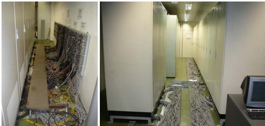
**Figura 4** – Borneira de rearranjo e instalação dos painéis automação.
