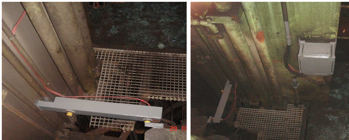
Figura 13. Novo local de instalação do sensor e nova caixa de passagem.
