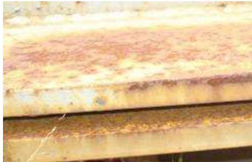
**Figura 16** - Corrosão uniforme e em frestas de um aço utilizado na estrutura da Escola de Minas.
