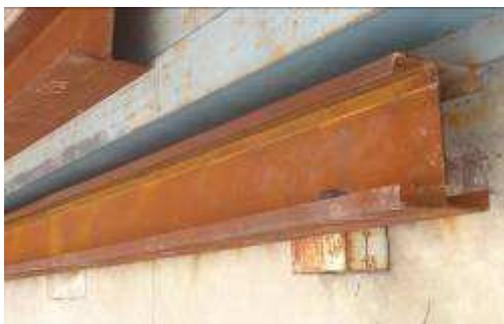
**Figura 10** – Corrosão uniforme em vigas de aço estrutural.
