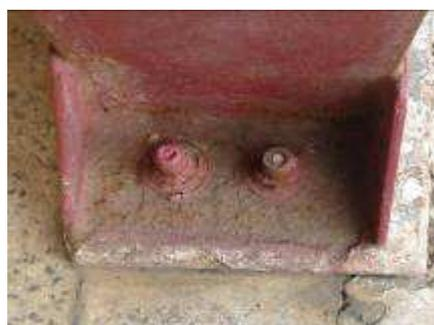
**Figura 13** – Corrosão uniforme e em fresta em aço estrutural pintado devido ao acúmulo de eletrólitos.
