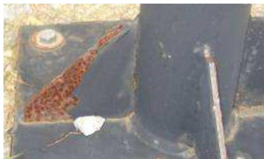
**Figura 17** – Corrosão uniforme, galvânica (região do parafuso) e em fresta na base de um poste de iluminação da UFOP.
