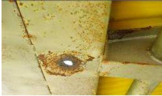
**Figura 18** – Corrosão uniforme e em fresta na cobertura da passarela da Escola de Minas, em aço carbono, região de pingadeira.
