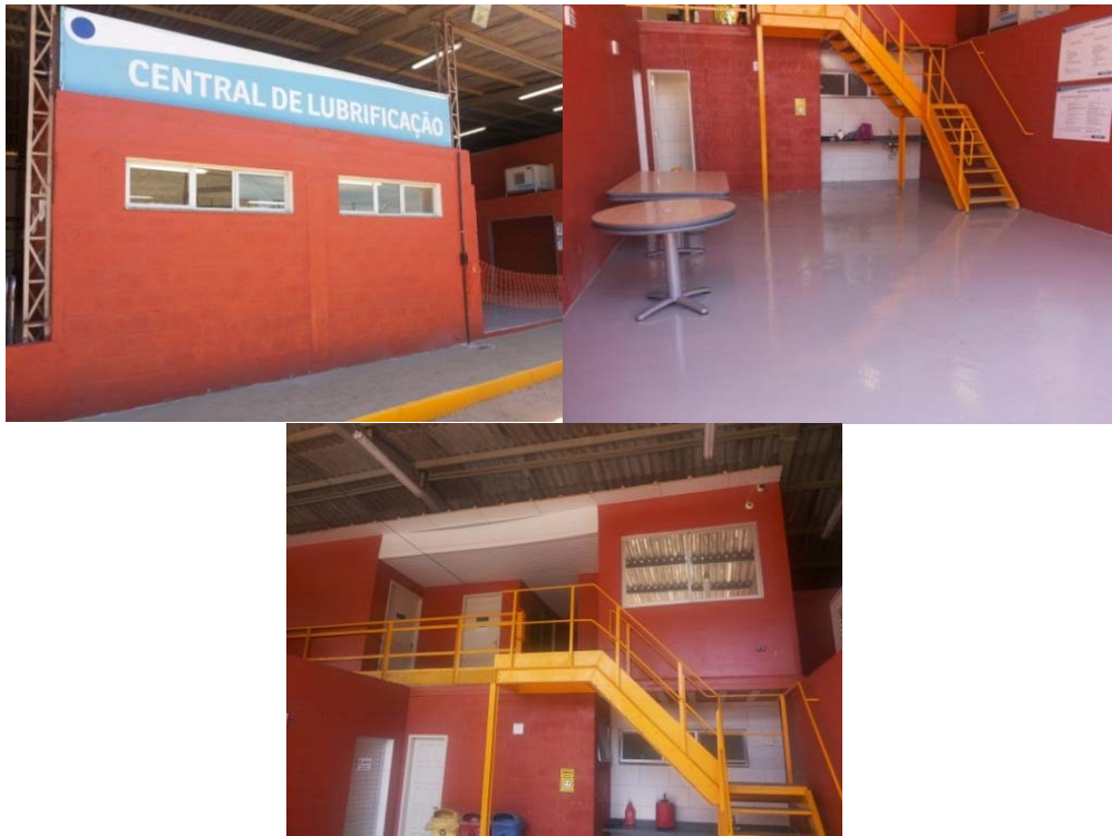
Figura 20: Entrada do galpão e piso superior com sala de treinamento e escritórios
