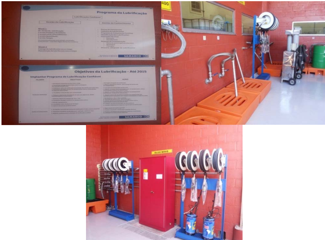
Figura 21. Banners do programa de Lubrificação Confiável e área de recebimento de óleo tratado no interior do galpão.
