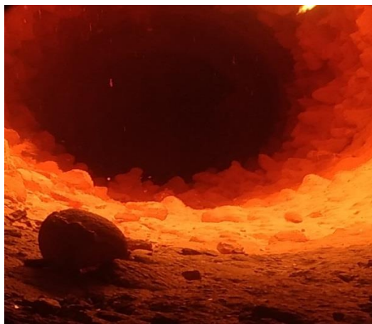
Figura 10. Crescimento de acúmulo de materiais nas paredes do forno rotativo
