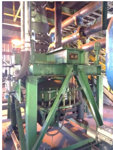
Figura 2. Dosadora de combustível sólido pulverizado CWF1000 da HCRDI.
