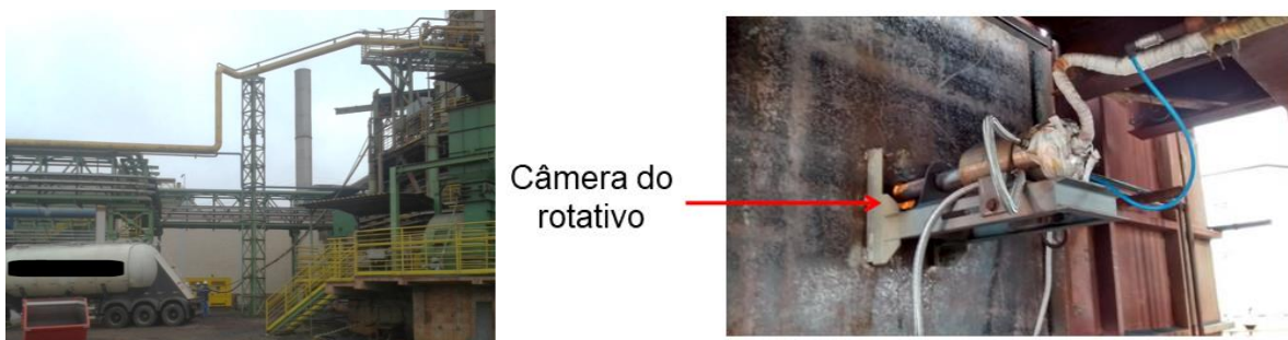
Figura 8. Instalação provisória para teste e câmera para monitoramento
