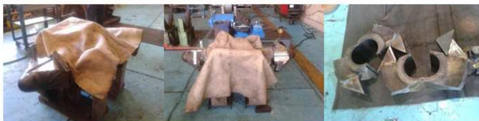
INSTALAÇÃO DE SUPORTES PARA APOIO DO MACACO HIDRÁULICO USADO NA ABERTURA DOS CUBOS SEM DANIFICAR O EIXO
