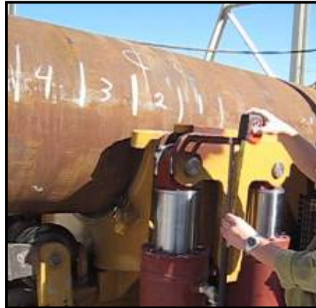
Figura 7. Medição do avanço do cilindro e acompanhamento do ângulo.
