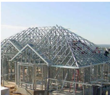
**Figura 11** – Casa em estrutura *Light Steel Framing*.
