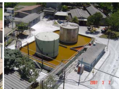
Figura 9 - Vista geral do Tanque 702
