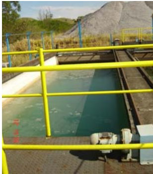
Figura 16 - Tanques onde é corrigido o pH para posterior descarte da água.
