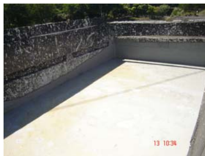
Figura 12 - Material do tanque 701 em estado semifluido
