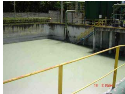
Figura 6 – Área para teste de neutralização
