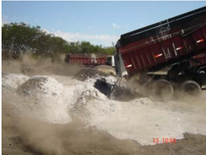
Figura 14 - Descarregamento do efluente no dique construído
