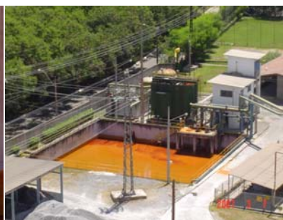
Figura 8 - Vista geral do Tanque 701
