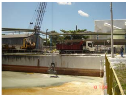
Figura 11 - Carregamento de caminhão com material do tanque 701
