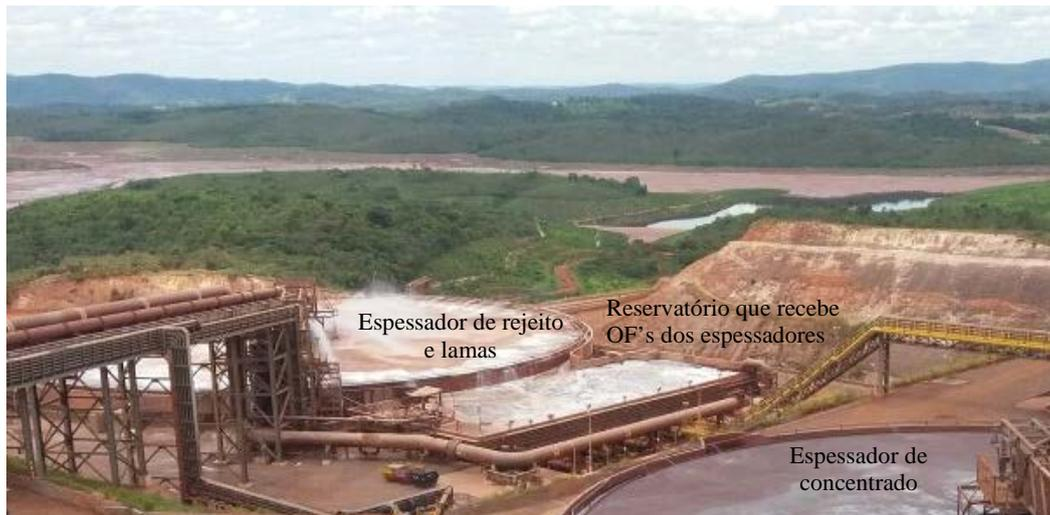
**Figura 2.** Circuito de reciclagem da água da usina de concentração do Minas-Rio.
