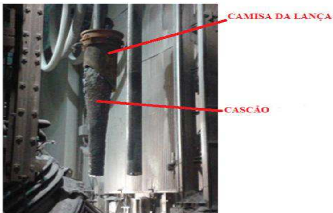
Figura 3 – Cascão excessivo - rompimento da camisa.
