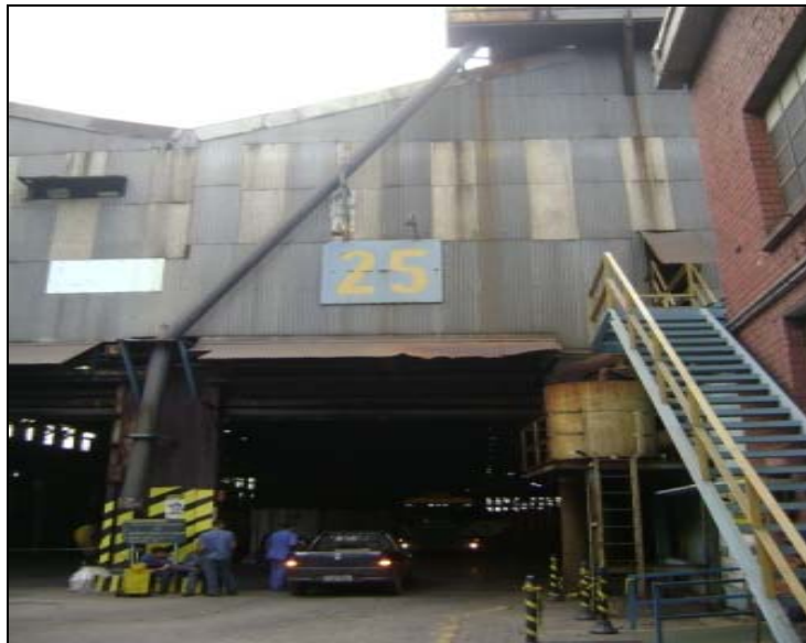
Figura 6. Vista da entrada do galpão EE-25.
