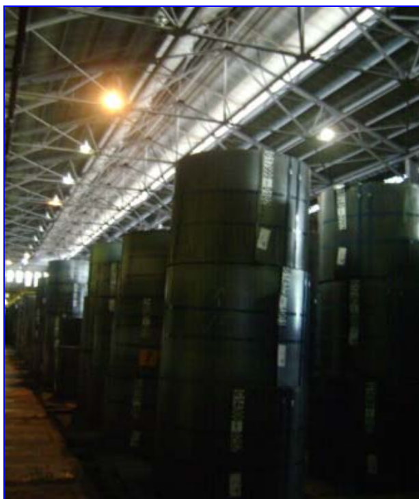
Figura 3. Vista da iluminação do galpão EE-25.
