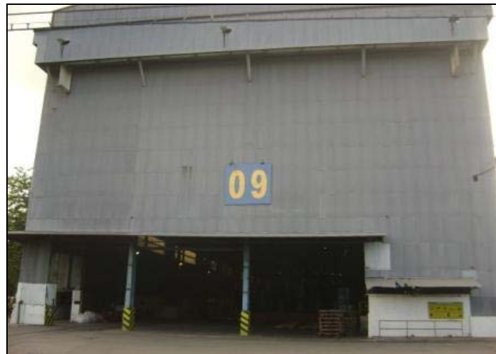
Figura 5. Vista da entrada do galpão EE-09.
