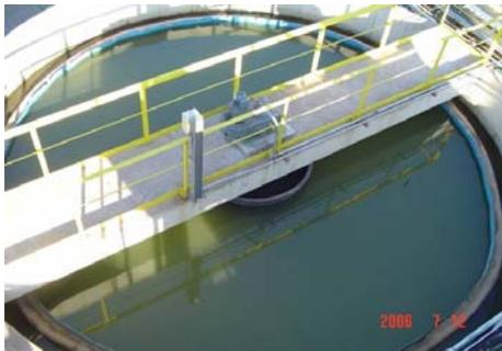
**Figura 11.** Espessador de lama
