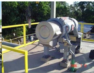
**Figura 16.** Desidratador de lama de água tratada (centrífuga)
