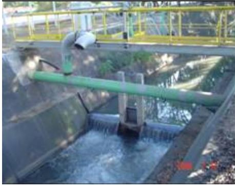
**Figura 5.** Barragem e sistema de comporta.
