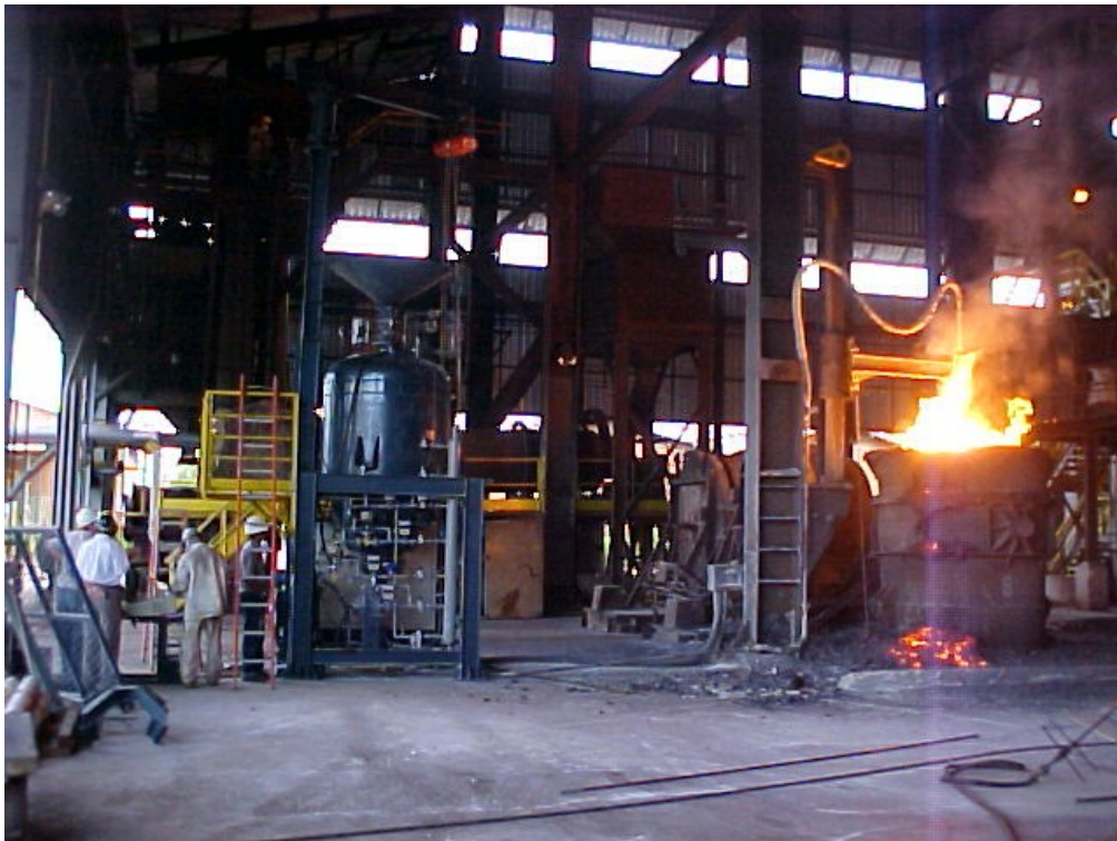
Figura 2 – Planta-piloto de dessulfuração em funcionamento.
