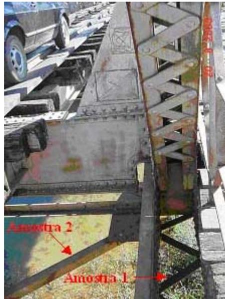
**Figura 2.** Locais de onde foram retiradas as amostras para análise química e metalográfica da PMH.
