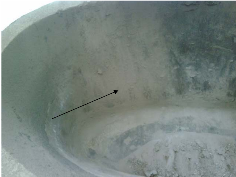
Figura 3 – Pote de Escória 01: Defeito interno que estrangula saída do cascão (“barriga”).
