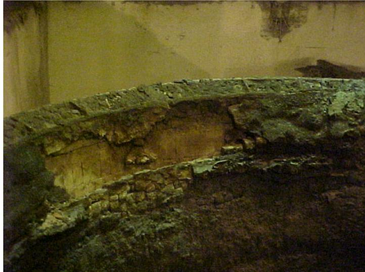
**Figura 1.** Queda de tijolo da borda da panela de aço.
