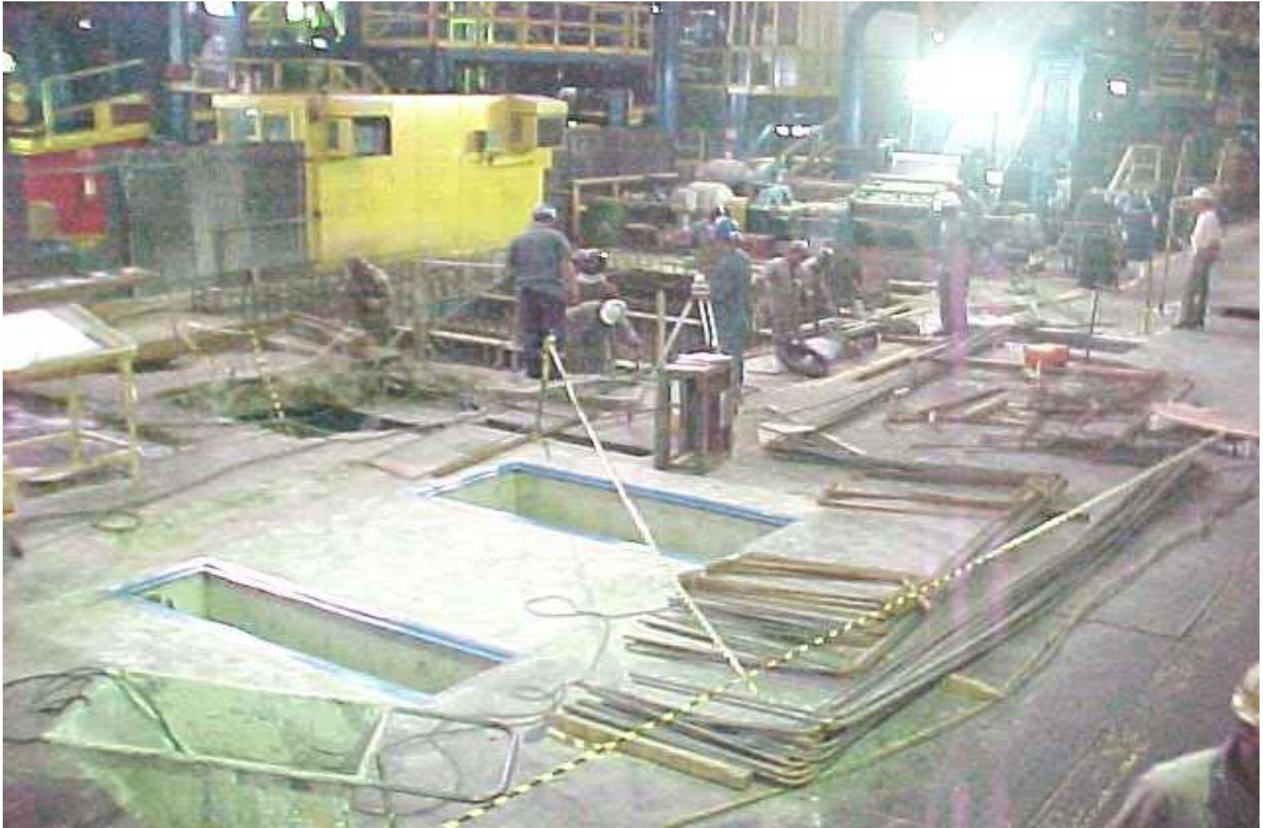
Fig 10 – Vista parcial da linha durante as obras civis. Ao fundo a LEE-2, que operou normalmente durante toda a obra.
