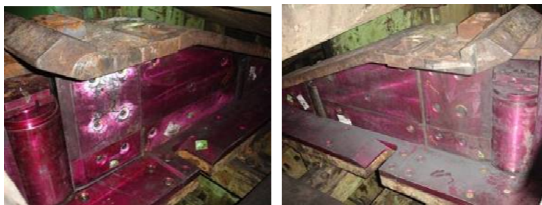
Fonte: Gerência de Manutenção Mecânica do Laminador – IAMT/ ArcelorMittal Tubarão. Figura 21. Instalação dos roletes nas guias.
