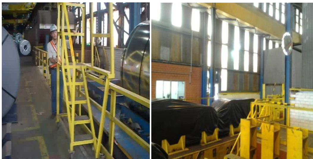
Figura 2. Instalação de escada móvel para acesso a caminhões e espelho parabólico para facilitar a visibilidade de manobras ferroviárias
