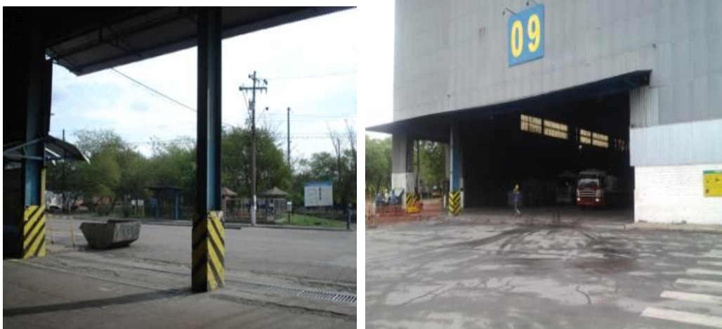
Figura 3. Retirada de coluna na baía de carregamento rodoviário para maior segurança e rapidez nas manobras de veículos e conseqüentemente rapidez no embarque de produtos.
