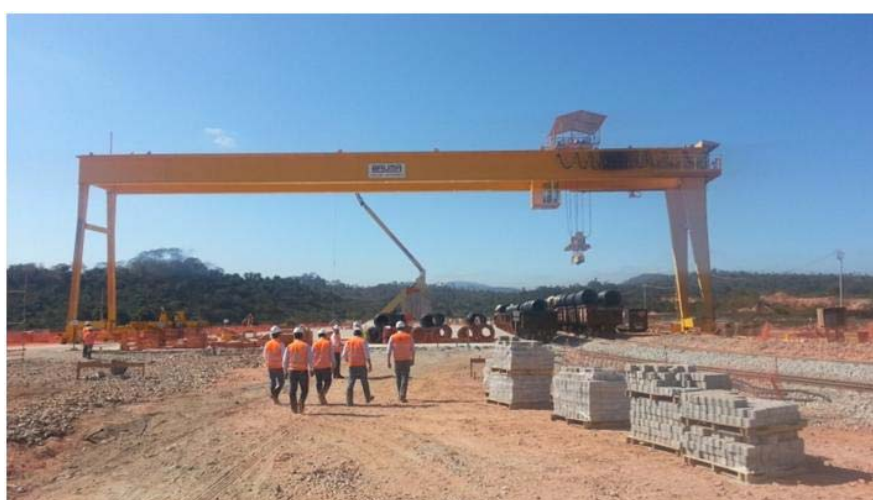
Figura 8. Construção do terminal TISL.
