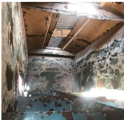
**Figura 2** – Corrosão na parte interna
