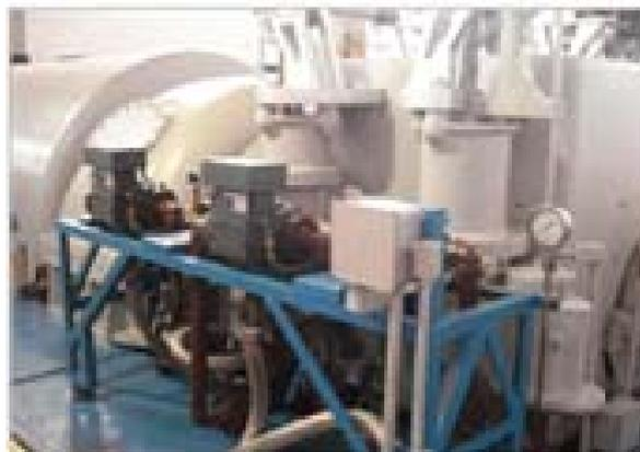
Figura 15. EHPS instalada próxima a turbina e ao cilindro de controle.
