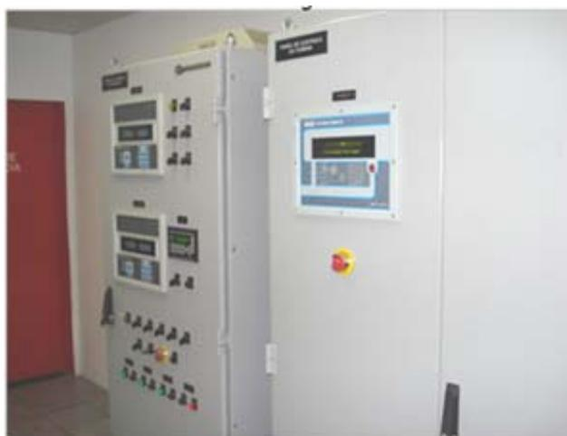
Figura 8. Painéis de Sincronismo da máquina e controle de carga / ilha.
