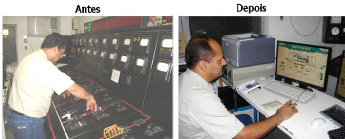
Figura 21. Sistema Supervisório de controle deo Turbo Gerador nº 03.
