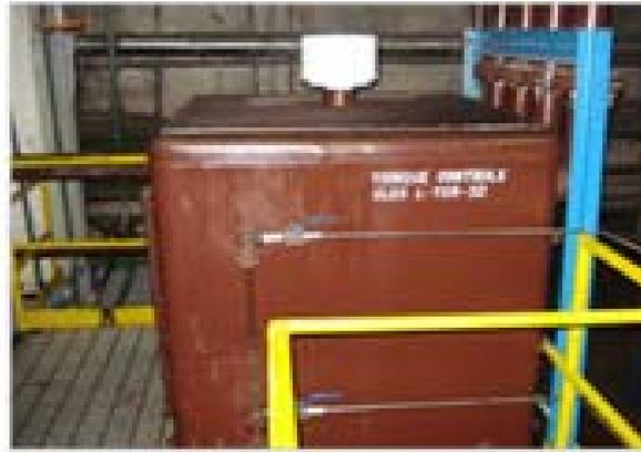
**Figura 16.** Tanque de óleo de controle isolado do óleo de lubrificação da máquina.
